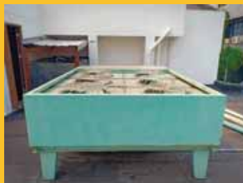
ก่อนปรับปรุง
